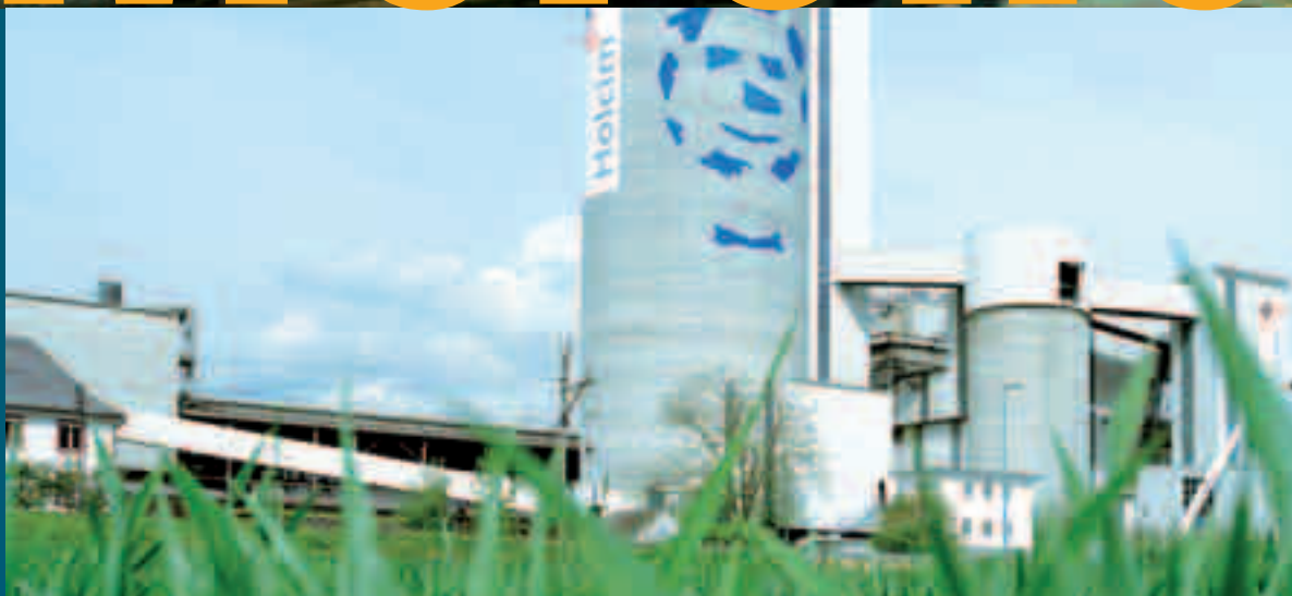
In alto un modellino di treno per il trasporto del cemento. A destra, gli impianti della Holcim.
