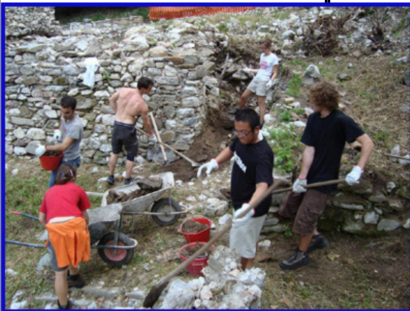
Una fase dei lavori a Second'Alpe
